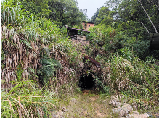
照片 6 工业场地+356.3m 平硐口
