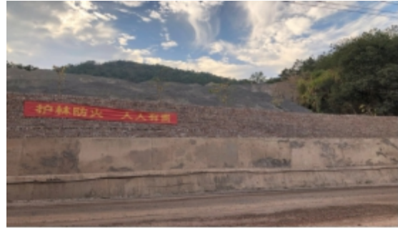
照片 2 又兴石场治理后挡土墙
