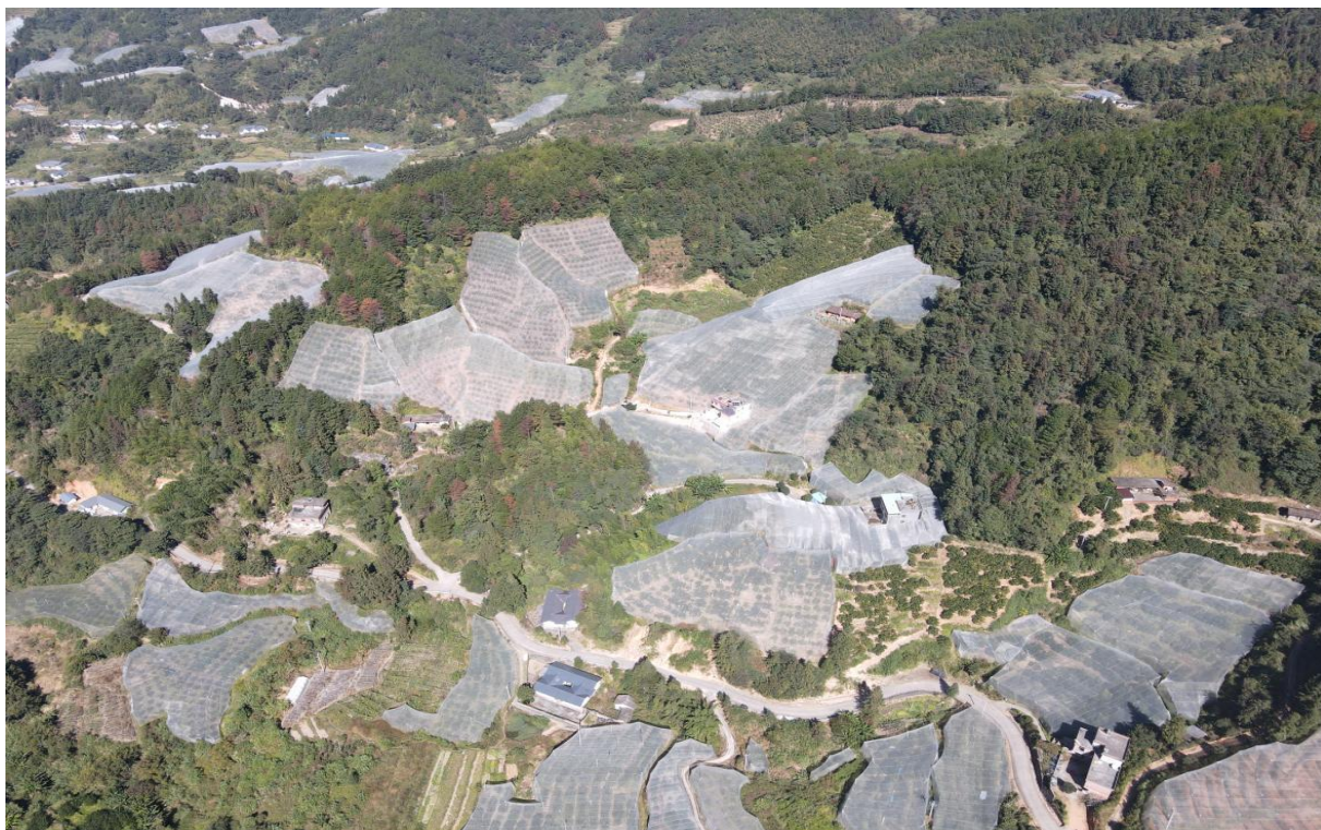
图 6.3-5 矿山复绿工程现状
