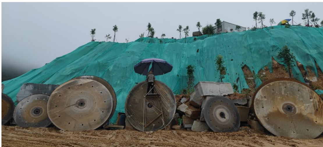
照片 2 排土场塑料薄膜遮盖
