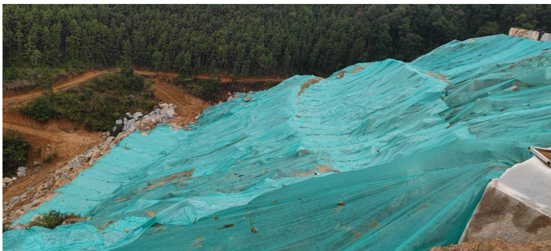
照片 1 排土场塑料薄膜遮盖
