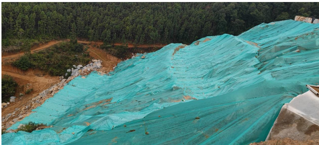
照片 1 排土场塑料薄膜遮盖
