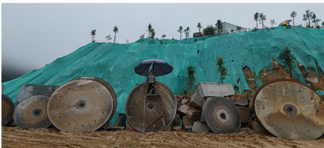
照片 2 排土场塑料薄膜遮盖
