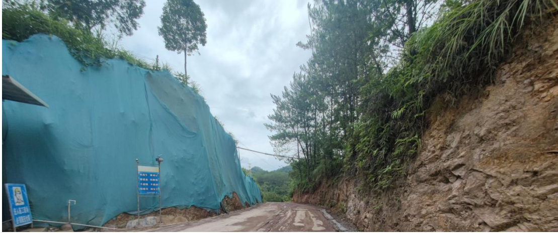
照片1 矿山入口一侧边坡铺设塑料薄膜治理
