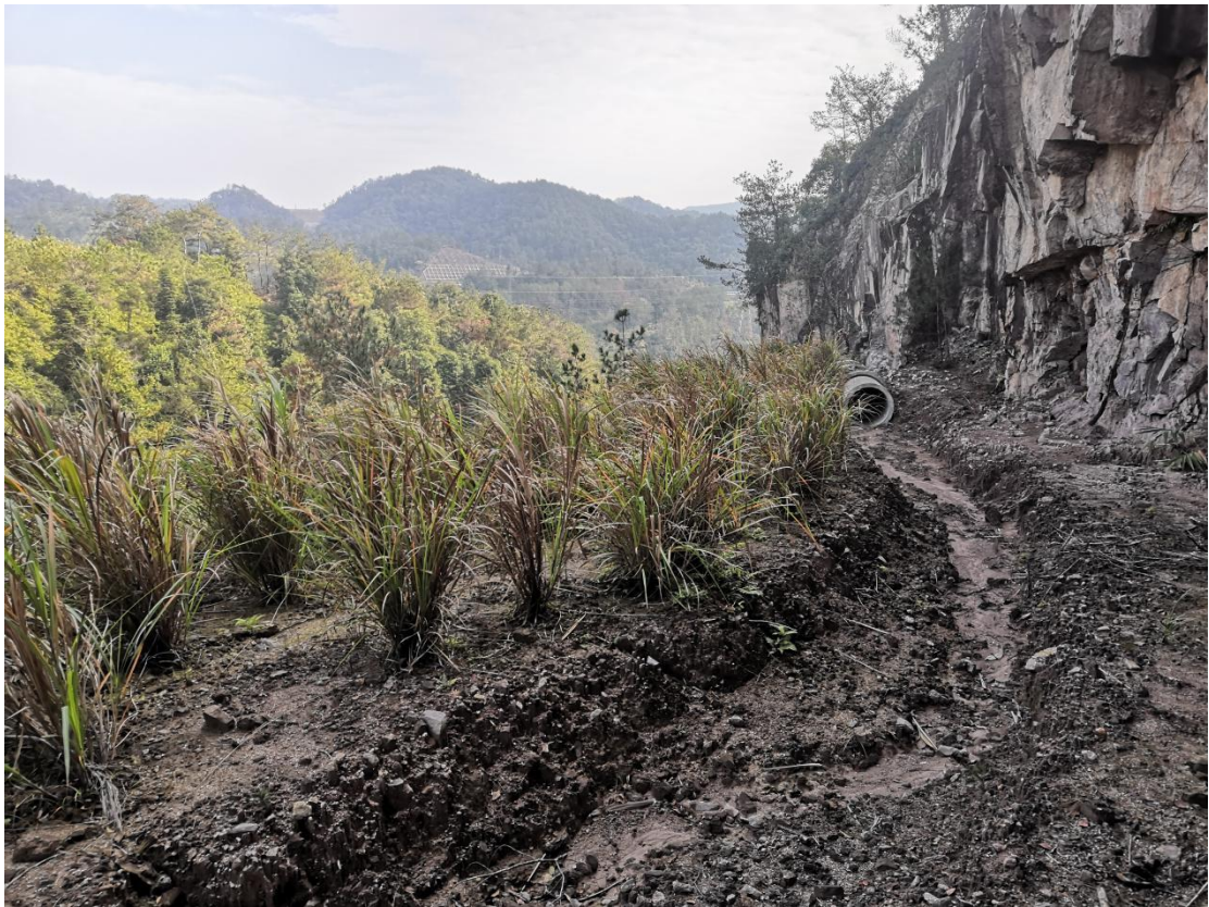
照片10 排土场复绿治理效果以及排水沟（排水涵管）
