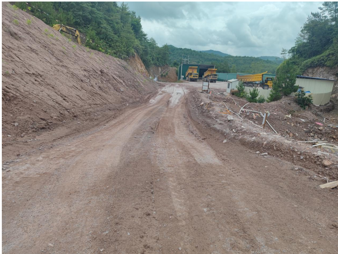
照片2 采场入口两侧警示带、警示牌治理
