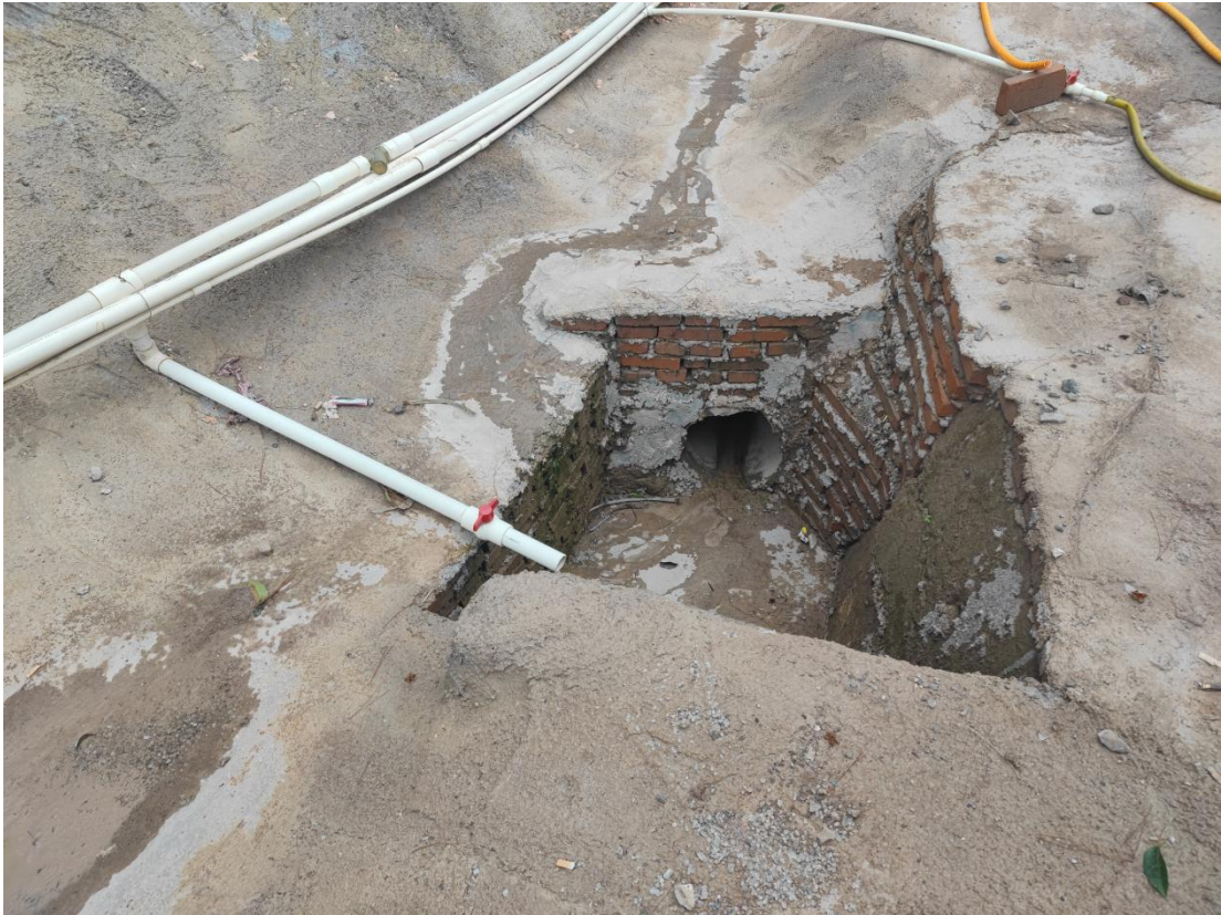
照片7 硬底化道路内侧排水涵管
