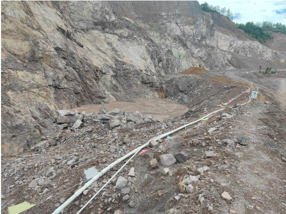
照片3 采场入口左侧沉砂池警戒线、警示牌治理
