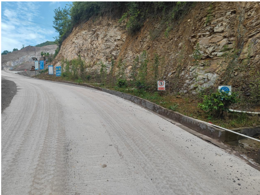
照片4 矿山进出道路铺设硬底化、内侧排水沟、转弯处设置警示牌治理
