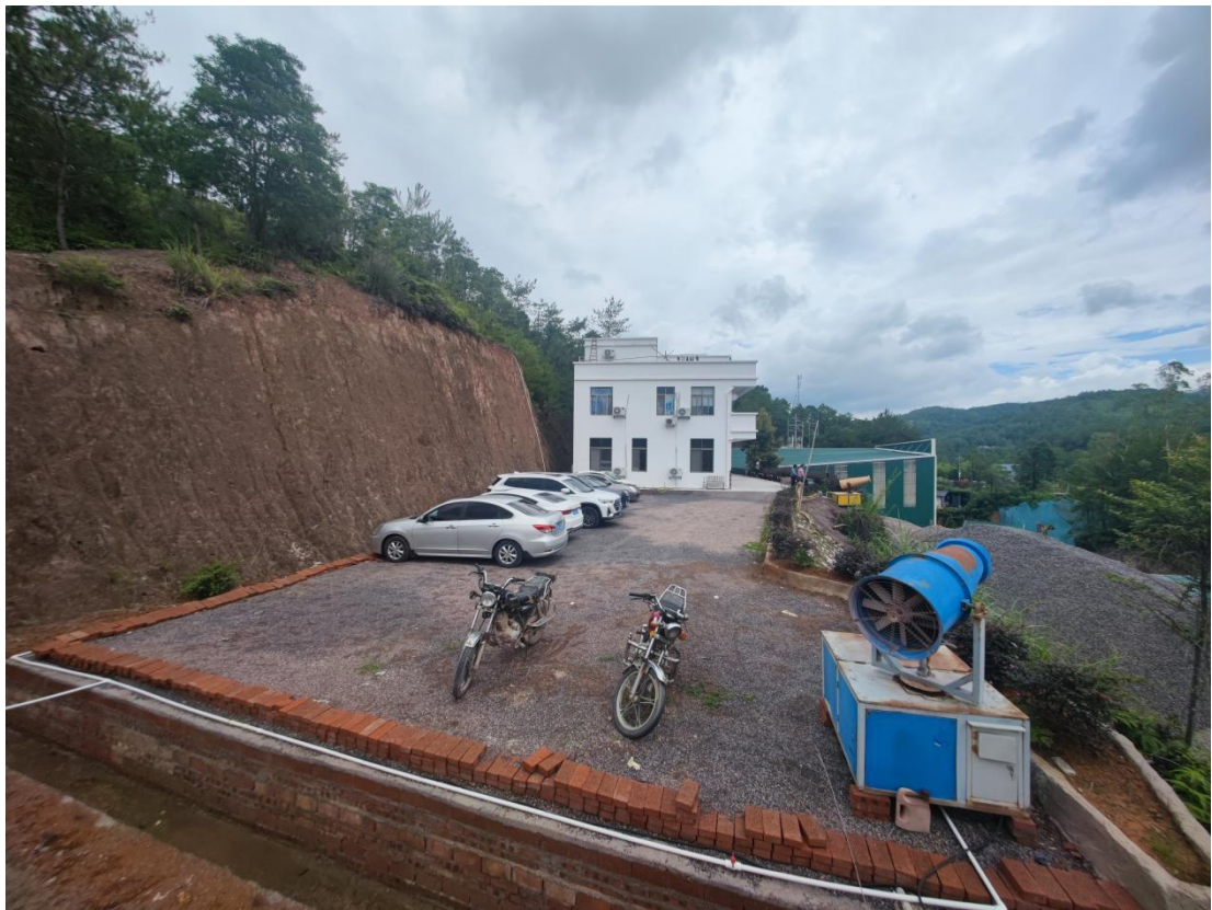
照片6 综合服务区、配套停车场及排水沟
