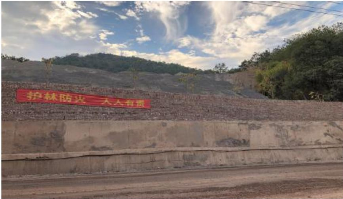
照片 13 治理后挡土墙
