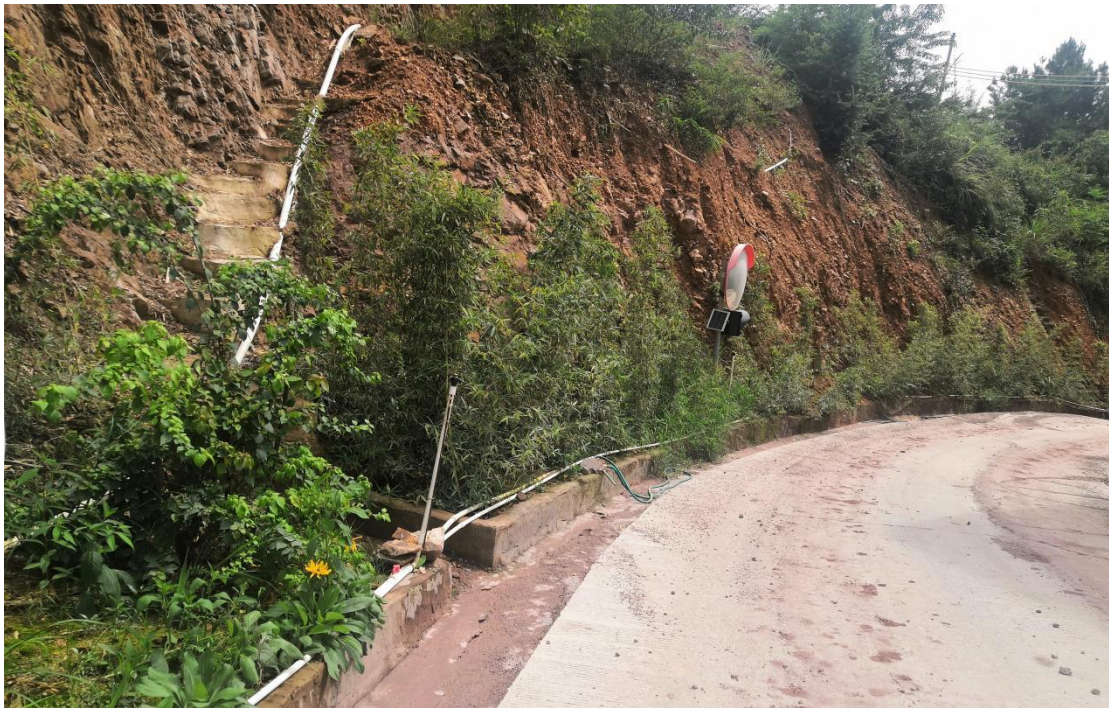
照片8 工业场地内侧矿山道路坡底复绿治理
