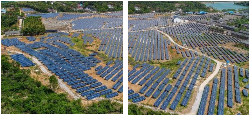
图2-5 东石镇光伏发电项目
