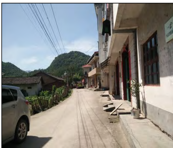
项目拟整治现状 5
