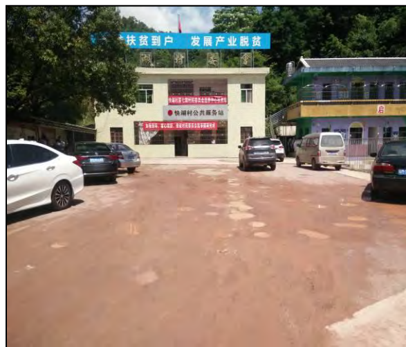
项目拟整治现状 2
