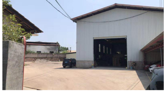
项目南面 无名汽车通讯设备厂房
