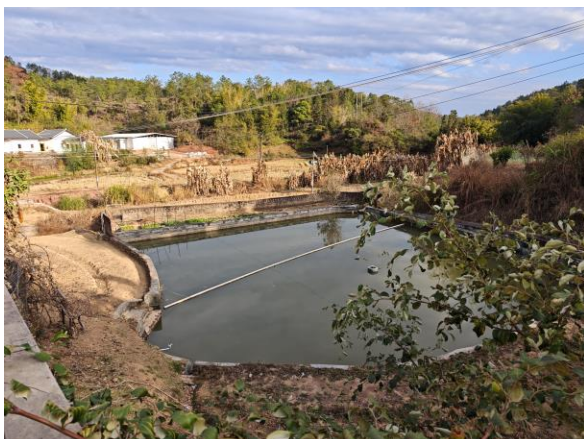
照片 17 1 号溪取水点照片
