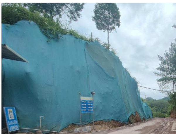
照片 3 露天采场入口左侧边坡治理
