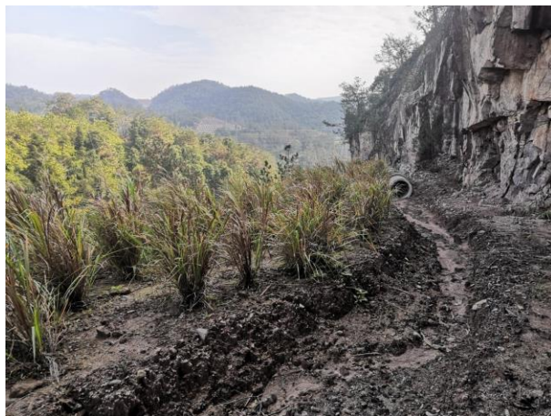
照片 8 原排土场复垦及排水管涵
